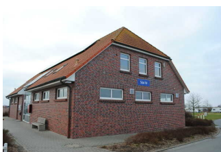
Kennzeichnung der Gebäude
