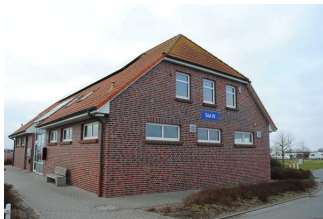
Kennzeichnung der Gebäude
