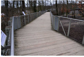
Holzbrücke und Wegschleife Kajaland
