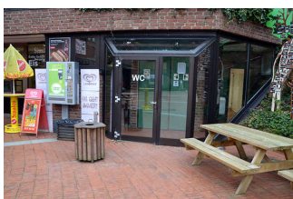
Tür zum WC-Flur
