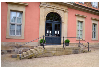
Treppe am Haupteingang
