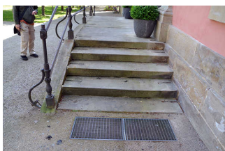
Treppe am Haupteingang
