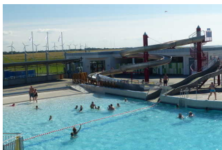
Rutsche im Außenbecken
