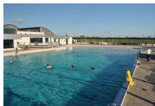
Weg außen rund um das Schwimmbecken
