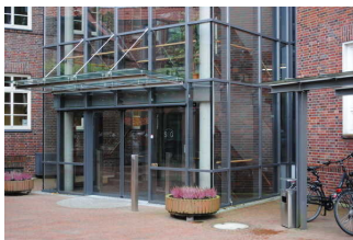
Eingang für Menschen mit Behinderung ( Parkplatz / ZOB )
