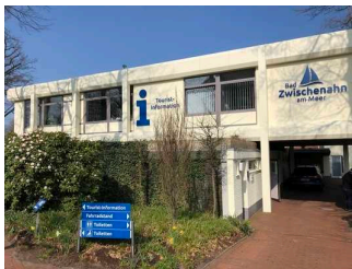
Außenansicht Tourist-Information Bad Zwischenahn
