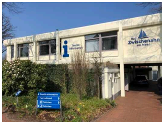
Außenansicht Tourist-Information Bad Zwischenahn
