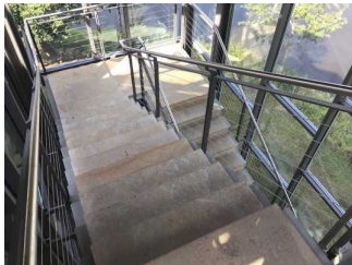
Glastreppenhaus vom UG bis Dachboden
