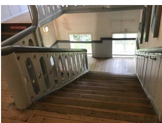
Treppe an der Kasse vom EG bis Dachgeschoss
