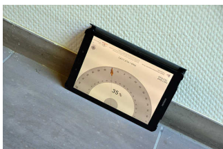
Rampe im Eingang
