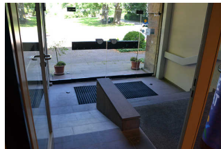
Rampe im Eingang
