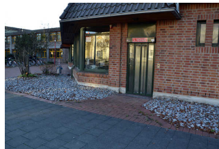
Aufzug zwischen Tiefgarage und Weg außen zur Rattenfänger Halle
