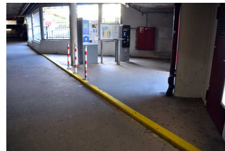
Weg vom Parkplatz zum Parkautomaten (alter Teil)
