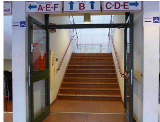
Tür zur Treppe der Tribüne
