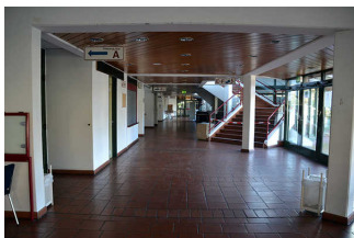
Weg im Foyer vom Eingang zu Treppen und Aufzügen
