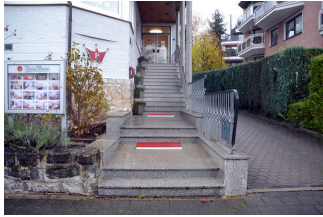
Treppe zum Eingangsbereich am Haupteingang
