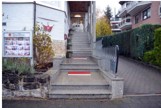
Treppe zum Eingangsbereich am Haupteingang
