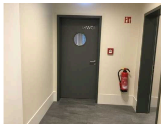
Flur zwischen Foyer/Aufzug und Treppenhaus
