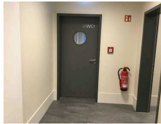
Flur zwischen Foyer/Aufzug und Treppenhaus
