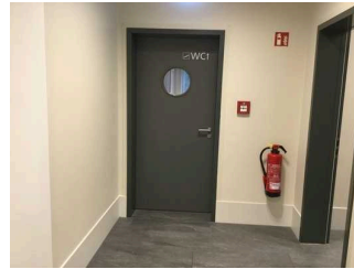
Flur zwischen Foyer/Aufzug und Treppenhaus
