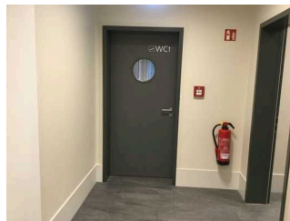
Flur zwischen Foyer/Aufzug und Treppenhaus
