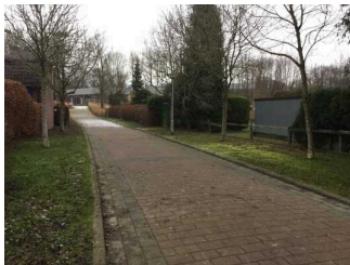
Weg außen vom Bussteig zum Eingang
