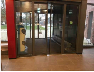
Windfang zwischen Eingang und Foyer
