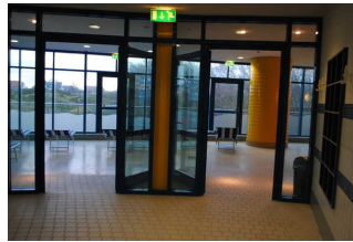
Türen in Ruheräume
