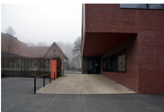
Rampe zum Museumseingang (Besucherzentrum)
