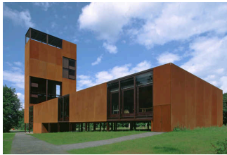
Gebäude der Dauerausstellung
