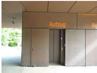
Eingang Aufzug Gebäude Dauerausstellung
