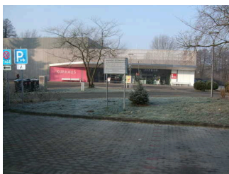
Blick vom Parkplatz zum Haupteingang Kurhaus
