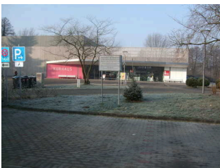
Blick vom Parkplatz zum Haupteingang Kurhaus
