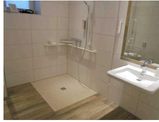
Ebenerdige Dusche mit waagerechten Haltegriffen
