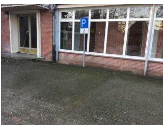
Parkplatz Jugendherberge Aurich
