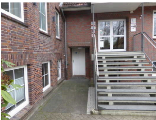
Aufzug und Treppe
