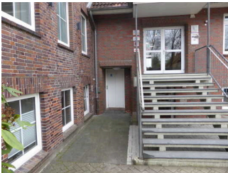
Aufzug und Treppe
