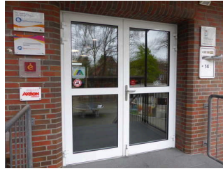
Eingangstür nach Treppe
