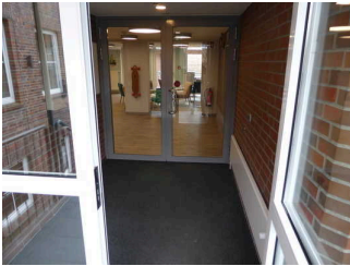
geöffnete Eingangstür nach Treppe
