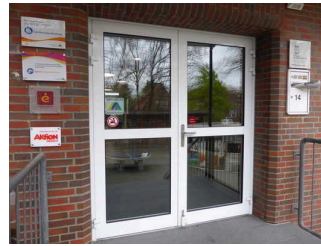
Eingangstür nach Treppe
