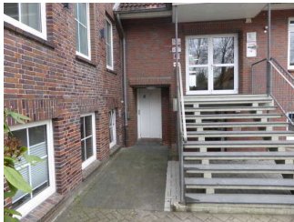
Aufzug und Treppe
