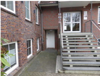
Aufzug und Treppe
