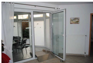
Rampe für Türschwelle zwischen Wohnzimmer und Wintergarten
