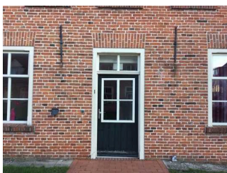
Nebeneingang zu Zimmer 30, Tagungsraum „Heisfelde“ und Öffentliches WC
