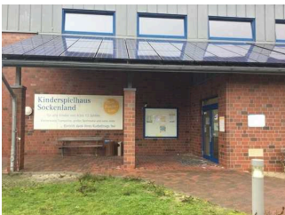
Eingangsbereich des Spielhauses Sockenland
