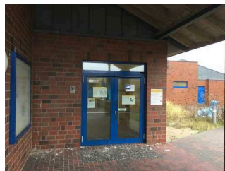
Eingangsbereich des Spielhauses Sockenland
