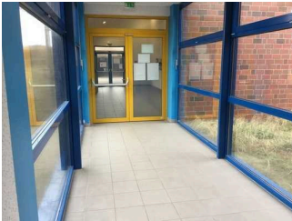
Tür zwischen Foyer und Flur zum WC für Menschen mit Behinderung
