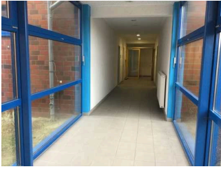
Flur vom Foyer des Sockenlandes zum WC
