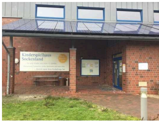
Eingangsbereich des Spielhauses Sockenland
