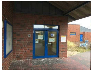
Eingangsbereich des Spielhauses Sockenland
