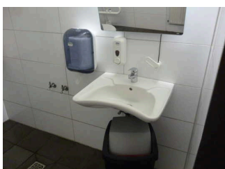
Waschbecken WC im Kellergeschoss
