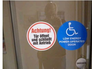
Detailansicht Glastür Seiteneingang
