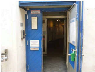
Seiteneingang der Lagerhalle
