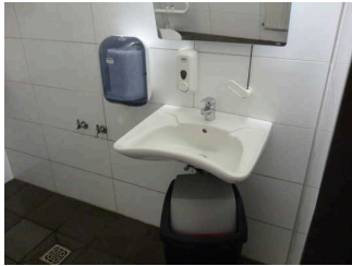
Waschbecken WC im Kellergeschoss
