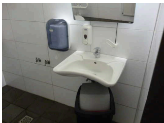
Waschbecken WC im Kellergeschoss
