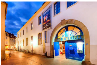
Außenansicht der Lagerhalle
