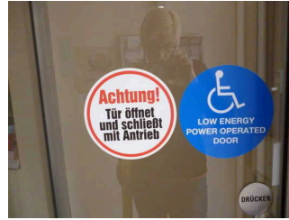
Detailansicht Glastür Seiteneingang
