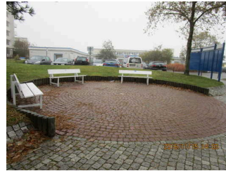
Rad- und Fußgängerweg bei der Bushaltestelle
