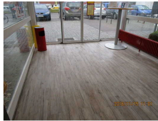
Fußboden und elektrische Schiebetüren im Vorraum der TI
