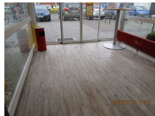
Fußboden und elektrische Schiebetüren im Vorraum der TI
