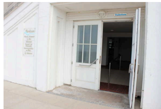
Zweiflügeltür – Blick von außen
