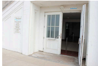
Zweiflügeltür – Blick von außen
