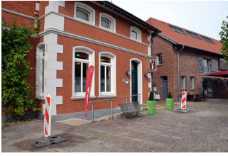
Rampe vor Eingang
