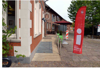
Rampe vor Eingang
