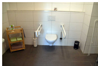
Sanitärraum mit Dusche und WC
