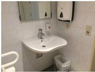
WC für Menschen mit Behinderung im Schwimmbadbereich
