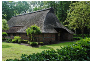
Gästeführung "Spaziergang durch Bad Zwischenahn"
