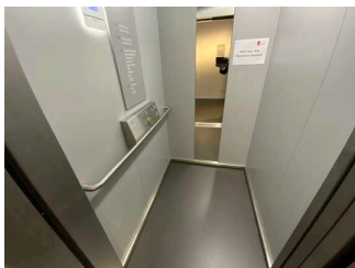
Aufzug (UG-2. OG)
