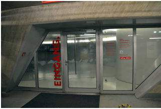
Zwischentüren auf dem Weg zu Treppe/Aufzug
