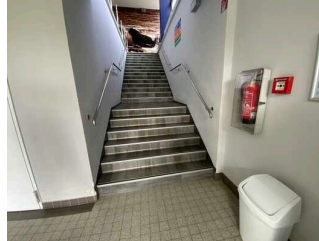
Treppe Foyer ins Untergeschoss
