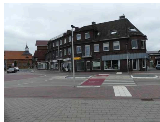
Blick vom Parkplatz zur TI Drochtersen
