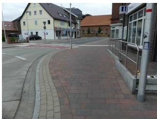
Weg vom Parkplatz zur Tourist-Information - Gehwegverengung
