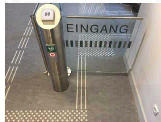
Zugangskontrolle zwischen Foyer und Treppenhaus
