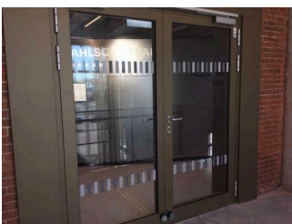
Tür zwischen Treppenhaus und Ausstellungsräumen im OG sowie im 1. und 2. OG
