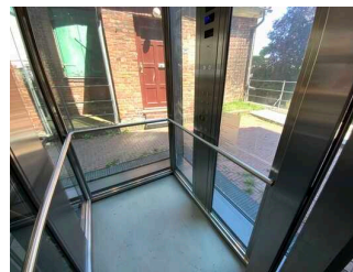
Aufzug EG bis 3. OG
