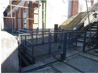
Der Einstieg in den Schrägaufzug ist eine ebenerdige Plattform, die rings herum mit Sicherheitsgittern umrandet ist. Diese sind ca. 1 m hoch.
